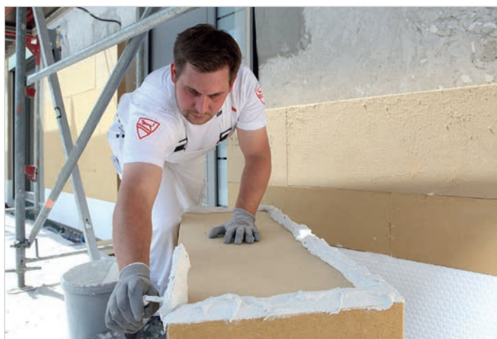
Fachleute verlegen die Holzfasermatten professionell.
