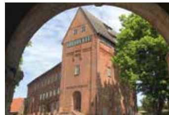
Das Kommandantenhaus wird aktuell saniert. Fotos: K. Haescher
