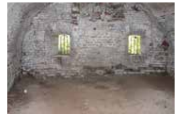
„Guck mal“: Im Innern der Kasematten in der Bastion „Drache“
