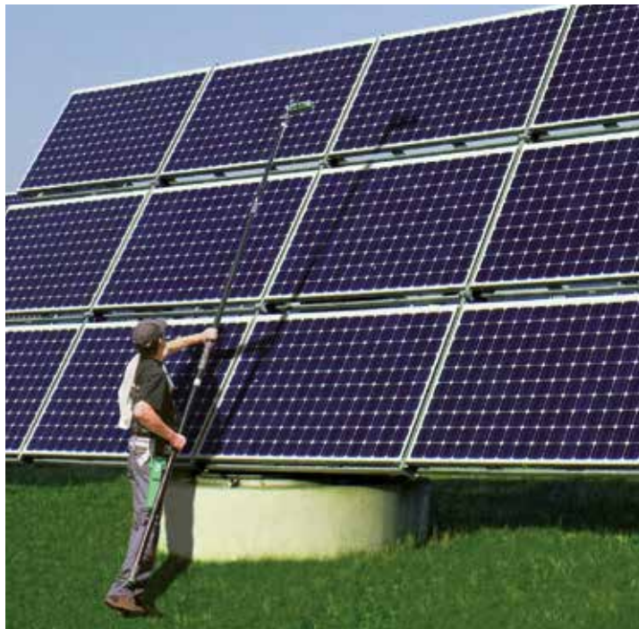
Solarmodule müssen professionell gesäubert werden. Optimal lassen sie sich mit Osmosewasser reinigen.
