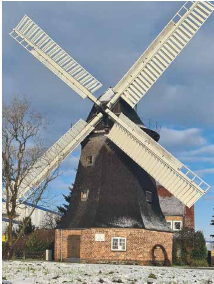
Die ebenerdig gebaute Anlage in Wittenburg wird als Erdholländer-Windmühle bezeichnet.
