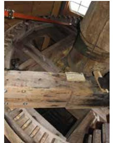
Über das Kammrad wird die Drehbewegung der Flügel übertragen.
