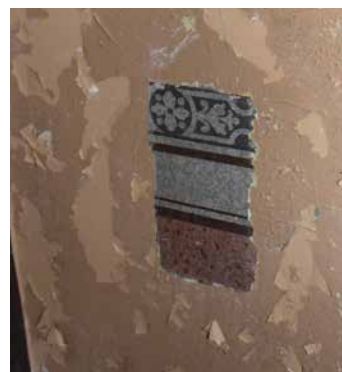
Eine bereits freigelegte Schmuckborde, vorher unter Farbe versteckt
