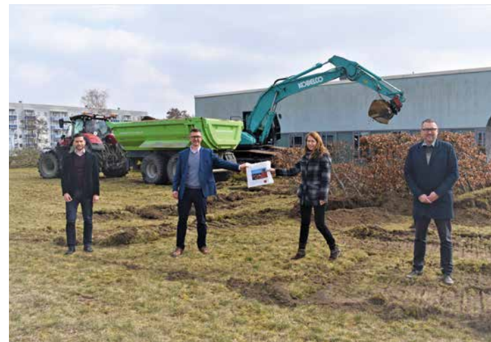
Startschuss des Neubaus am PITZ: Parchims Bürgermeister Dirk Flörke (r.) und Wirtschaftsförderin Anja Bollmohr sicherten den RoweMed-Geschäftsführern Frank Dietrich (l.) und Dirk Forberger Unterstützung zu. Foto: T. Schünemann
