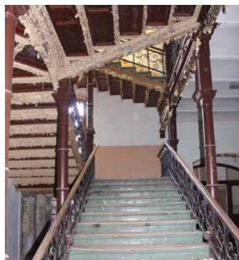
Blick ins Treppenhaus des rund 2000 Quadratmeter umfassenden Hauses
