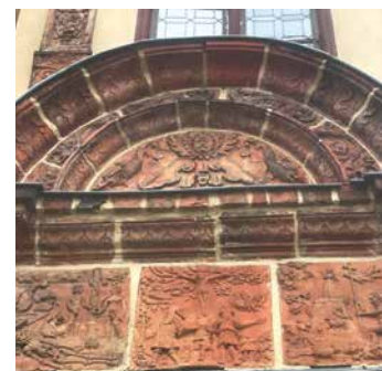
Detail von der Fassade des Gadebuscher Schlosses Foto: K. Haescher
