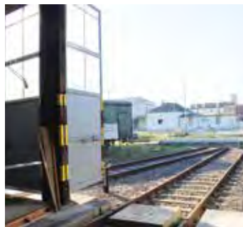
Zwölf große Flügeltüren und Gleise, die bis ins Innere des Schuppens führen, gehören zur Anlage.
