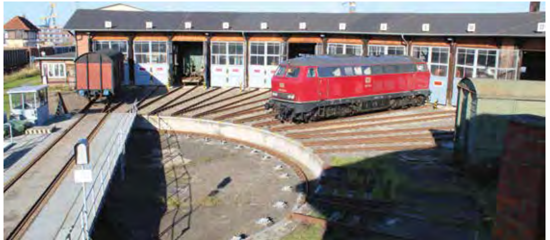
Der Ringlokschuppen mit der Drehscheibe, die Richtungswechsel von Lokomotiven möglich macht. Fotos: Katja Haescher
