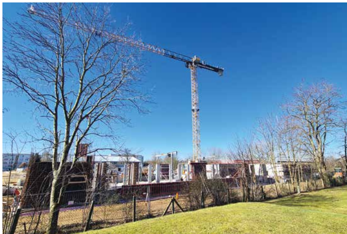
In Grevesmühlen entsteht ein neuer Schulcampus, die Hochbauarbeiten haben begonnen. Foto: Volkmar Eggert
