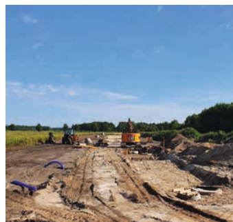
Die Erschließungsarbeiten haben begonnen.
