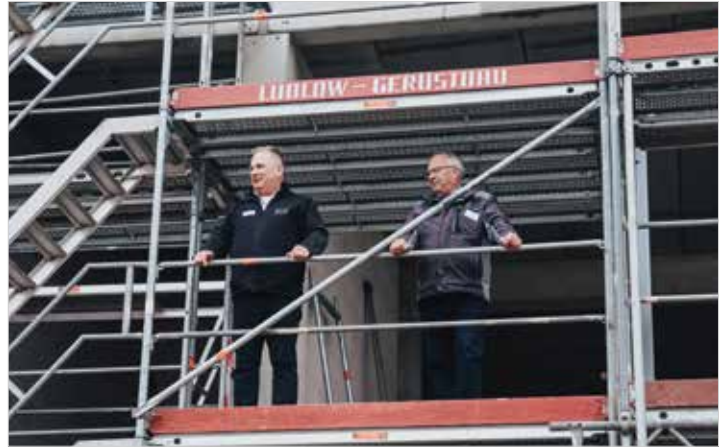
bmp-Geschäftsführer Ingo Küster (l.) und Henry Huber von der Dachdeckerei Huber auf dem Gerüst der Großbaustelle Foto: bmp production GmbH
