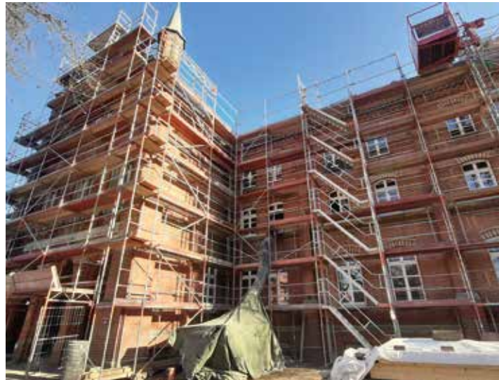
Das „Haus B“ am Überregionalen Förderzentrum „Sehen“ in Neukloster wird seit 2019 aufwendig saniert. Nächstes Jahr soll es fertig werden. Foto: LK NWMe
