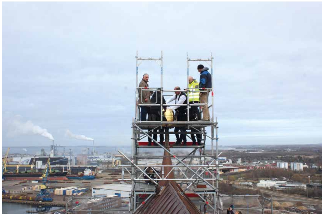
Die Turmbekrönung der St.-Nikolai-Kirche in Wismar glänzt nun wieder in einem frischen Gold.
