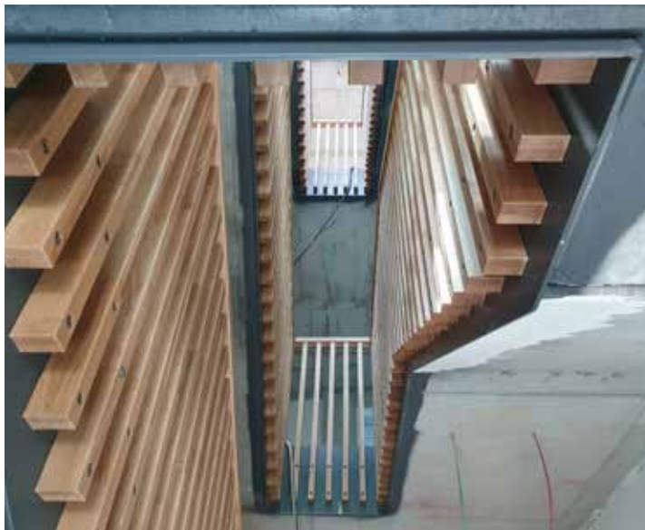
Im künftigen Schulcampus in Grevesmühlen werden Holz und andere heimische Rohstoffe verwendet.
