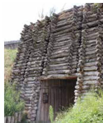
Die Holzkonstruktion des Tunneltors war ursprünglich mit Erde verkleidet.
