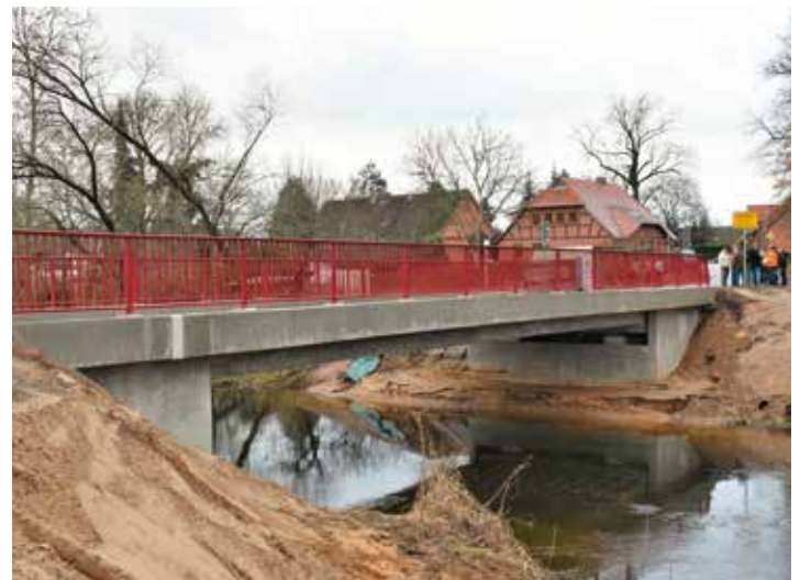
Das Projekt Brückenneubau blieb im Zeit- und Budgetrahmen.
