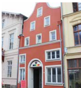
Mit einem ziegelroten Anstrich wurde die Fassade aufgewertet.
