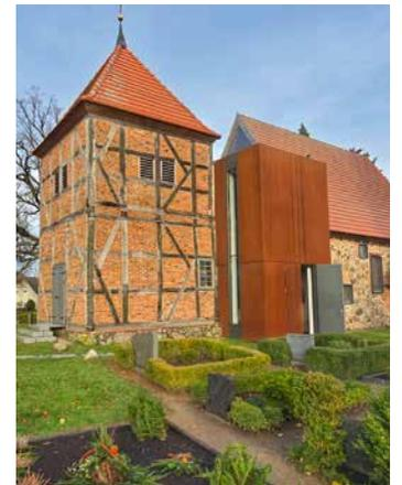
Ein Stahlelement verbindet Turm und Kirchenschiff.
