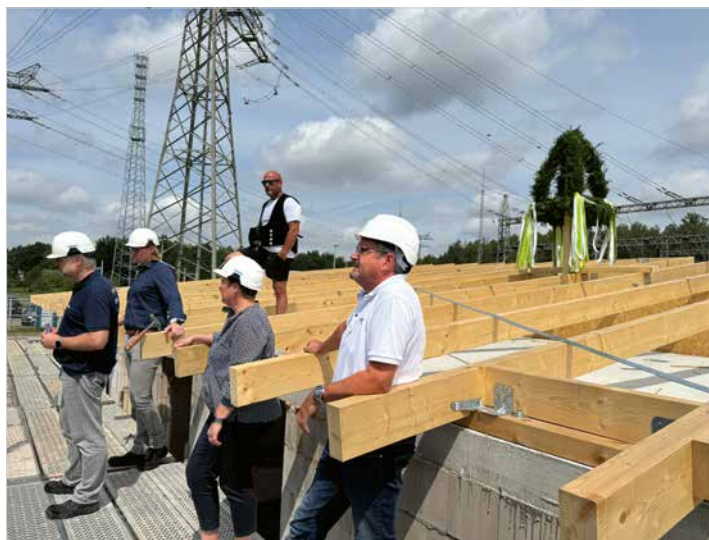
Richtfest am neuen Gebäude für die Netzdienststelle Hagenow. 14 Arbeitsplätze werden hier später zu finden sein.
