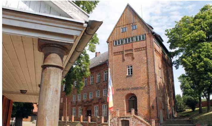
Das Kommandantenhaus der Festung Dömitz soll mit Hilfe des Geldes gesichert werden.
