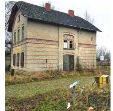
Eines der so genannten Beamtenhäuser
