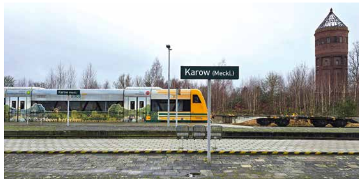
Einer von zwei Wassertürmen, die zu dem Areal gehören: Die Zeit hat auch hier ihre Spuren hinterlassen.
