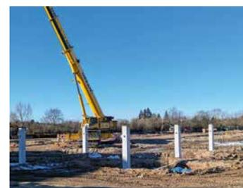
Die Stützen wurden mit Hilfe des Krans in die Erde gesetzt und im Fundament verankert. Foto: Ulrike Auge
