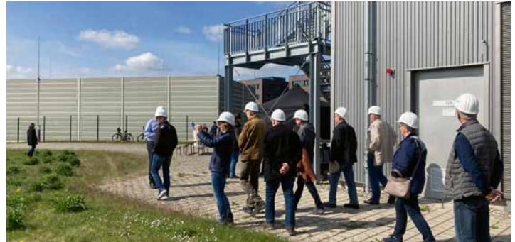
Im Batteriespeicher der WEMAG in Lankow werden mehrere Führungen stattfinden. Foto: WEMAG
