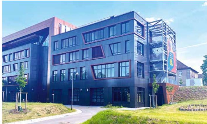
TGZ-Standort Schwerin: Das neue Haus 7 des TGZ bietet Platz für Büros, Labore und Produktionsstätten.
