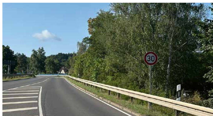
Zusätzlich zu Tempo 30 ist die Brücke seit diesem Monat nur noch einspurig befahrbar.
