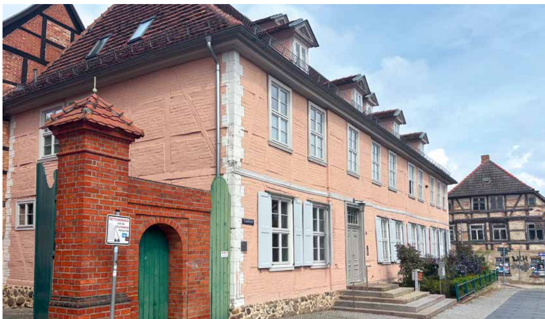
Das Adelspalais mit der doppelten Gaubenreihe steht heute unter Denkmalschutz.
