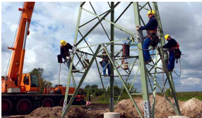
Mit regelmäßigen Investitionen trägt die WEMAG Netz GmbH zur Netzstabilität bei.
