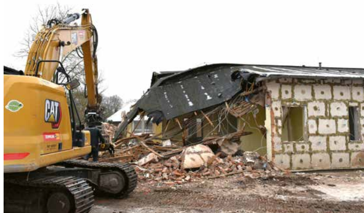
Mit dem Abriss des ehemaligen Hortgebäudes starten die Bauarbeiten an der Goethe-Grundschule. Foto: Axel Schott
