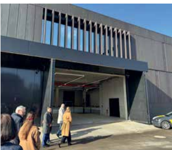
Hinter den Toren liegt der Schleusenraum.
