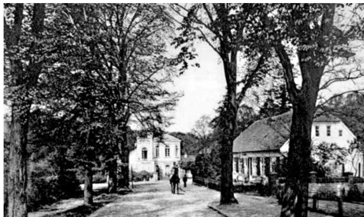
Das Bild, fotografiert aus der Schlossgartenallee in Richtung Greenhouse, zeigt rechts das Hofgärtnerhaus um 1907 – und damit vor dem Umbau.
