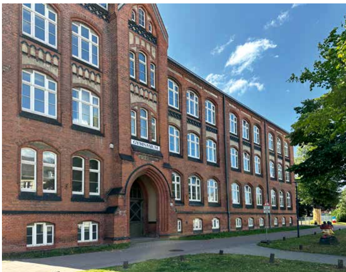
Das Gerhart-Hauptmann-Gymnasium bekommt eine Erweiterung, gleichzeitig wird das Gebäude saniert.
