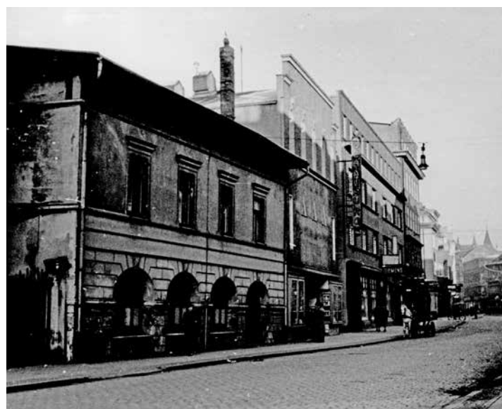
Laut Bauakten war das Gebäude in der Kaiser-Wilhelm-Straße 55 ab 1891 Spritzenhaus.
