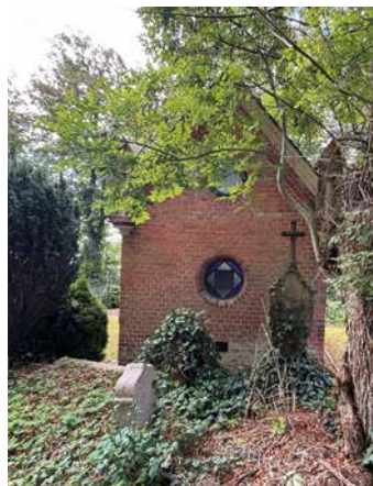
Die Grabkapelle Keding ist im neugotischen Stil erbaut.
